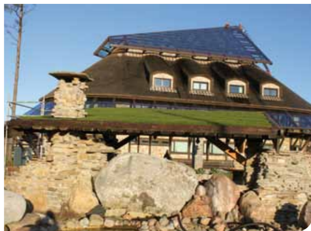
Viherkatto ulkorakennuksen katolla.
