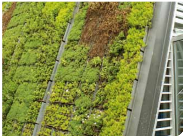
Vihreitä seiniä voi tehdä istuttamalla taimia istutuslaatikoihin tai -kennoihin.
